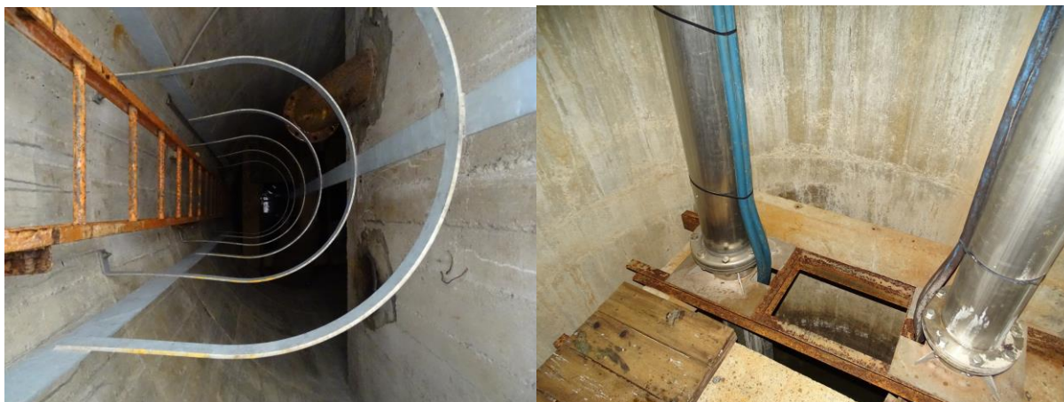
Le captage de Couthiol –vue plongeante du puits – colonnes montants des pompes en bas du puits
